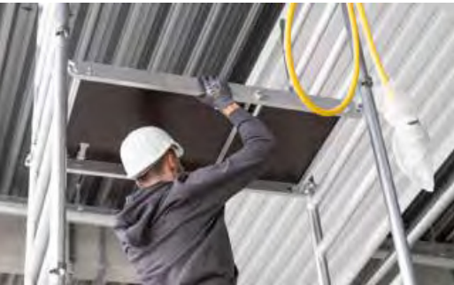
Weitere Aufsteckrahmen einsetzen Obere Plattform einhängen
