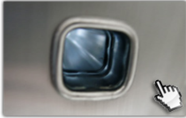
4-fach gebördelte Sprossen-Holmverbindungen
