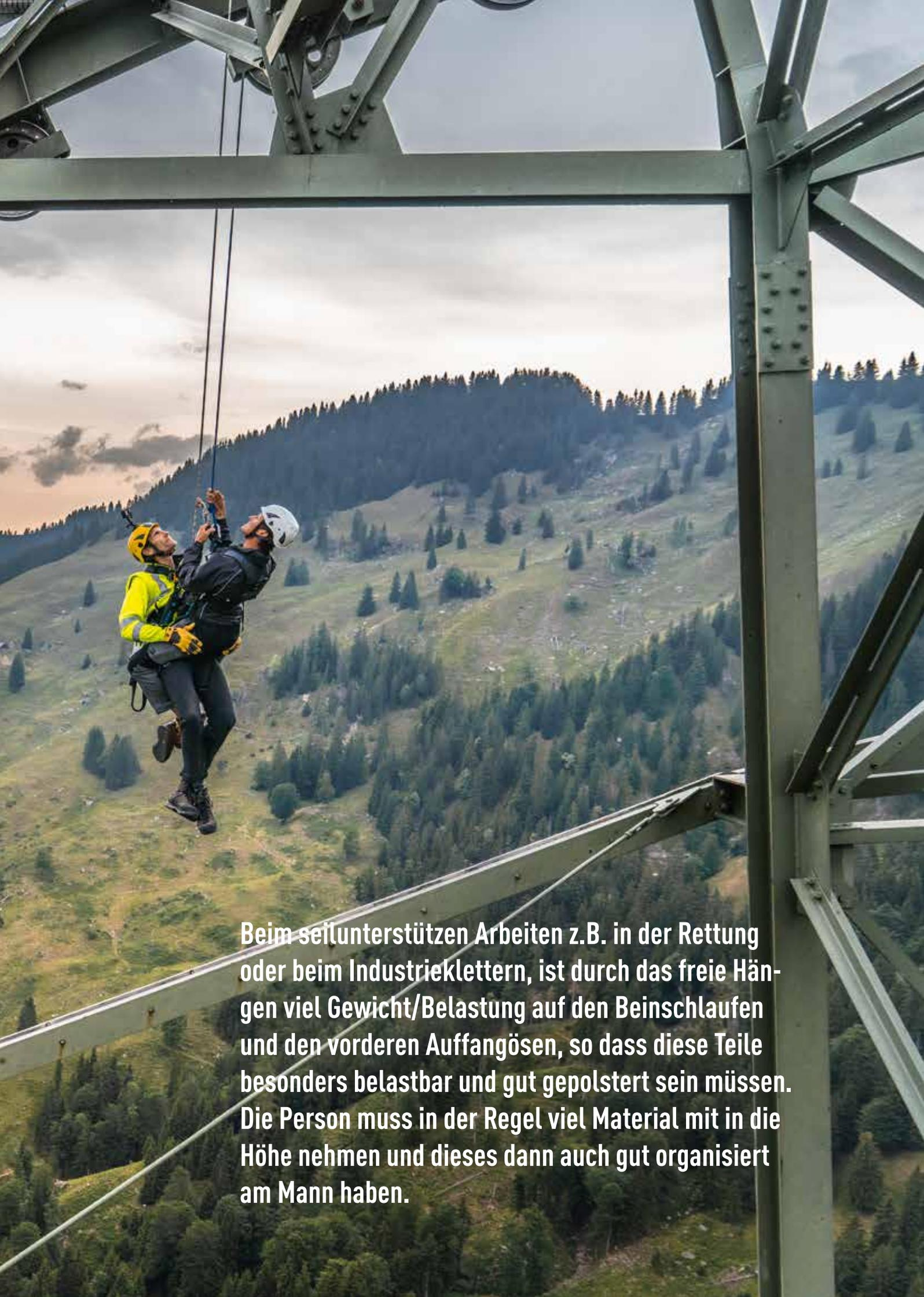
Beim seilunterstützten Arbeiten z.B. in der Rettung oder beim Industrielklettern, ist durch das freie Hängen viel Gewicht/Belastung auf den Beinschlaufen und den vorderen Auffangösen, so dass diese Teile besonders belastbar und gut gepolstert sein müssen. Die Person muss in der Regel viel Material mit in die Höhe nehmen und dieses dann auch gut organisiert am Mann haben.
