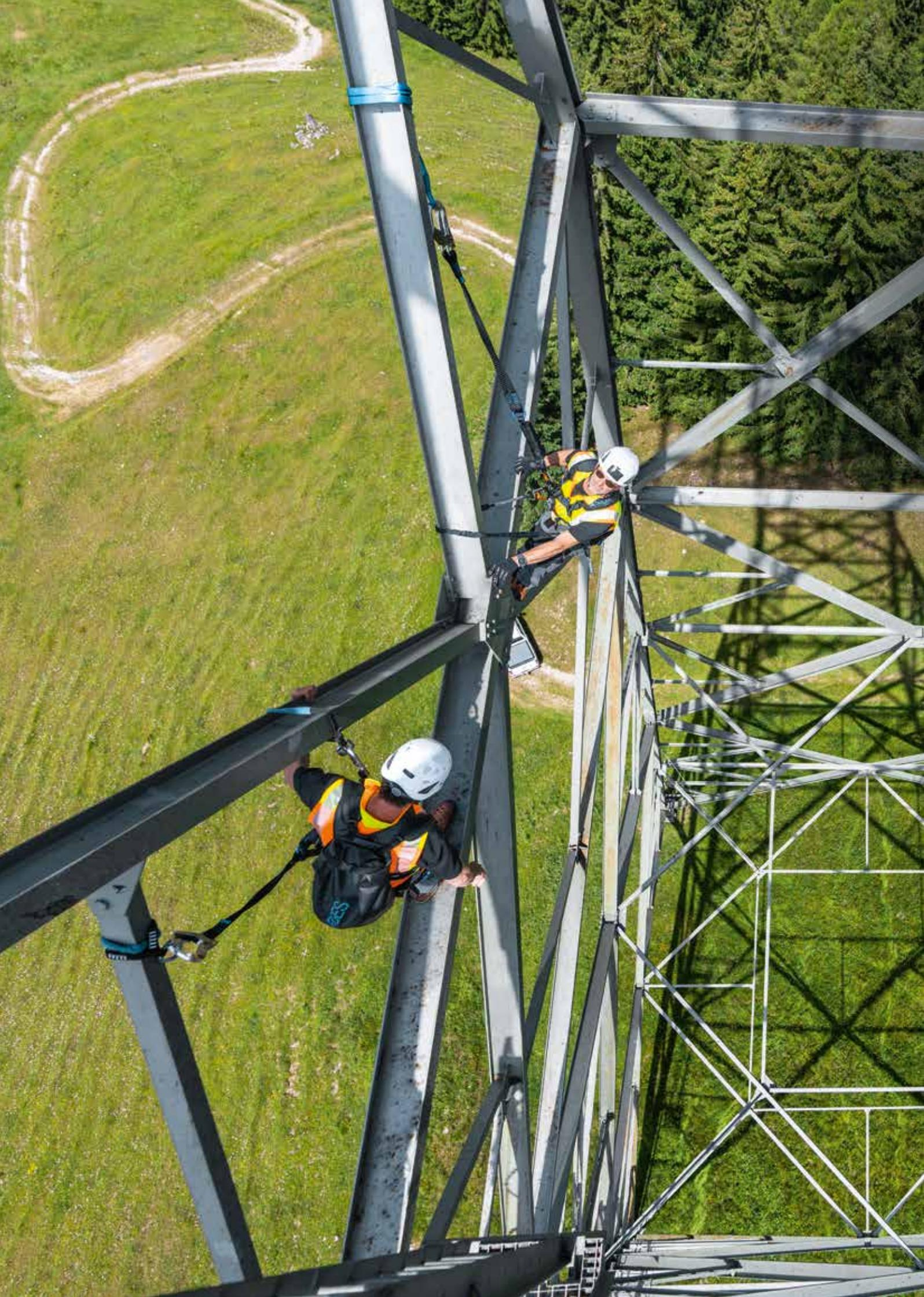
Bei Wartungsarbeiten in großer Höhe z.B. an Strom- und Telekommunikationsmasten oder Windkraftwerken ist der Wartungsmonteur teils extremen Wind- und Wetterverhältnissen ausgesetzt. Die Materialien für die Absturzsicherung werden durch den täglichen Einsatz stark beansprucht. Deshalb muss sich der Anwender auf ein robustes und komfortables Equipment verlassen können. Zudem muss die Ausrüstung so beschaffen sein, dass alles Notwendige schnell und sicher zur Hand ist.
