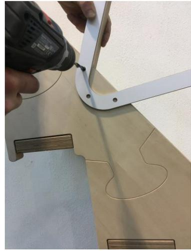
**1.1** Nutzen Sie die vorgebohrten Löcher im Handlaufmodul, um die Löcher auf die Außenwangen der Treppe zu übertragen. Mittels einer Schraubzwinge lässt sich ein Verrutschen der Module während des Bohrens verhindern. Bohren Sie mit einem 9mm Holzbohrer möglichst gerade von beiden Seiten zur Hälfte durch die Wange, um die Passgenauigkeit zu gewährleisten.
