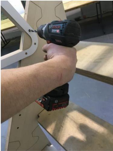
**1.1** Platzieren Sie die Handlaufmodule auf der Außenwange der Klapstertreppe so, dass diese sich jeweils in der Mitte eines Wangenpuzzleteils befinden. Es bietet sich an, am Austritt der Treppe zu beginnen, um einen gleichmäßigen Abstand zwischen den Handlaufmodulen herstellen zu können.
