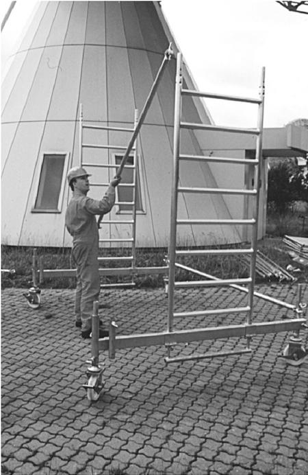
**Abb. 8 + 9** Diagonalen einhängen und sichern. Die Montage der Diagonalen erfolgt möglichst weit außen.
