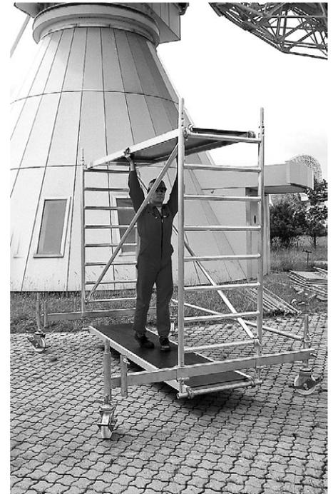
**Abb. 10** Plattform mit Durchstieg in die obersten Sprossen einhängen und sichern.
