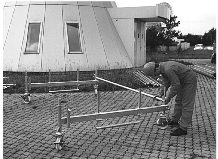
**Abb. 7** Fahrbalkenverlängerung in Fahrbalken einschieben und befestigen. Fahrbalken aufrichten und Basisrohr montieren oder Plattform einhängen.
