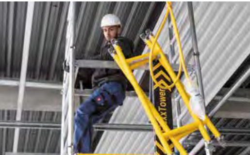
Weitere Aufsteckrahmen einsetzen Obere Plattform einhängen
