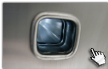
4-fach gebördelte Sprossen-Holmverbindungen
